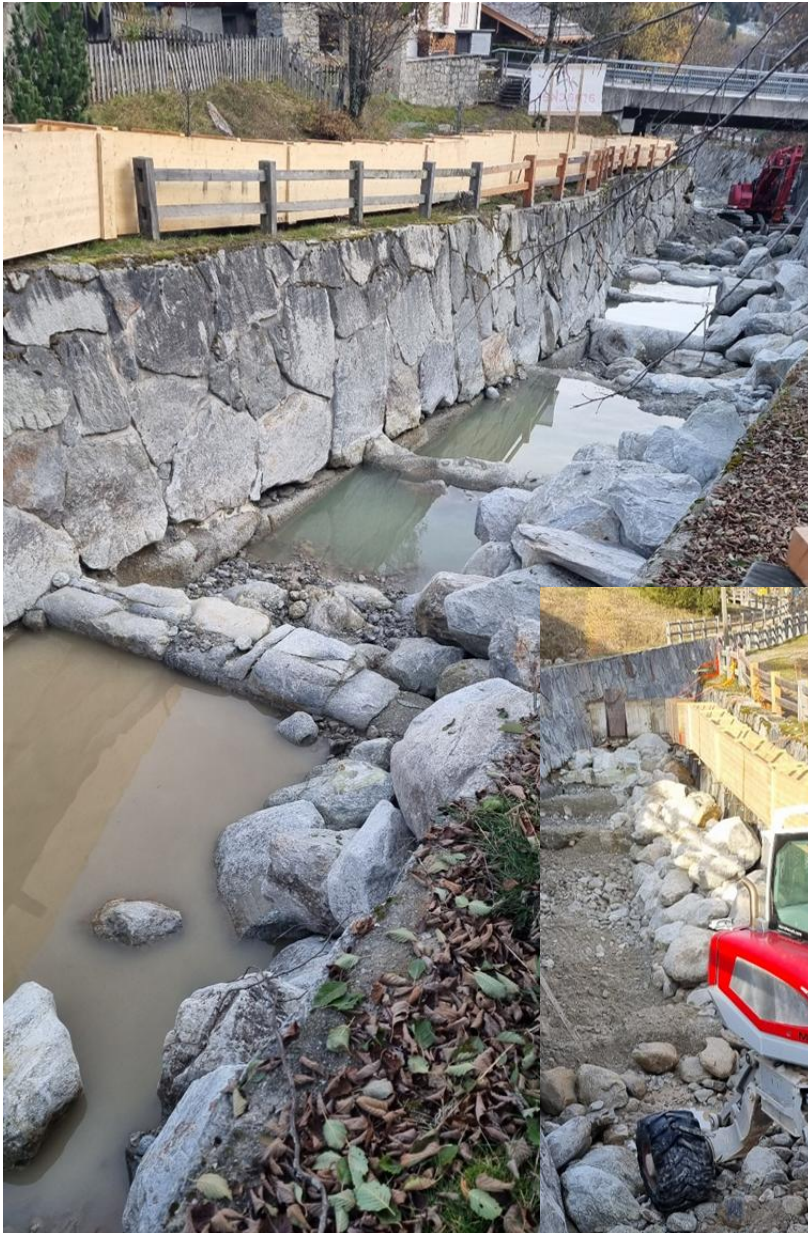
Starke Unterspülungen an der Mauer
